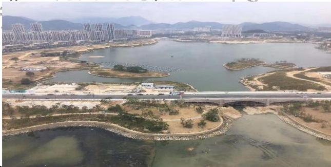
浙江宁海县，上游雨水蓄滞先行、中游管网分片直排、下游内河排蓄相结合。通过河道整治，设置人工湖、滞洪区等措施，加强城区排水滞涝能力，其中典型工程是颜公河综合整治，主要包括颜公河干流整治和163万立方米颜公河（天明湖）调蓄池工程。
