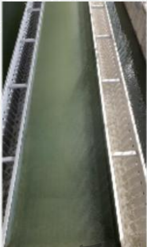
沉淀池（改造前）
