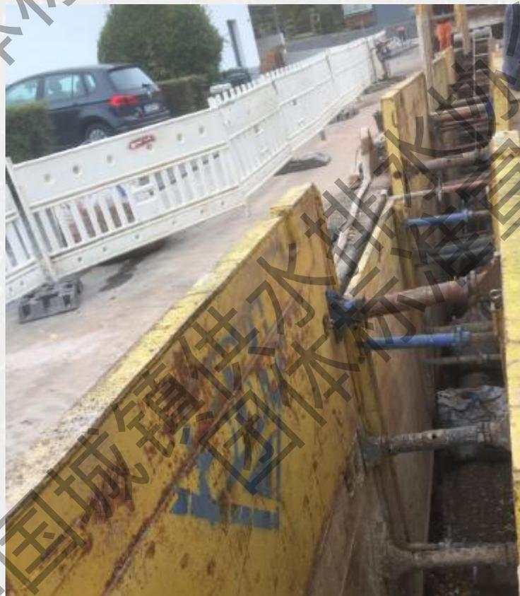
钢板桩支护的沟槽
