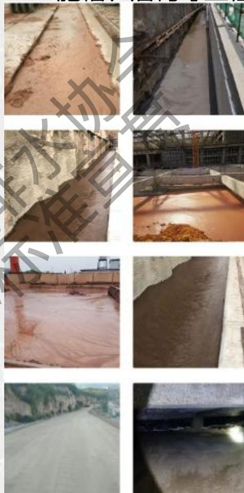
**【工程概况】**港城广场建设项目(08-1地块),地上6层,地下2层,基坑面积12422m<sup>2</sup>,基坑周长490m,肥槽平均宽度约1.5m,深度约10m,总体量约5000m<sup>3</sup>,采用流态固化土进行肥槽回填施工。
