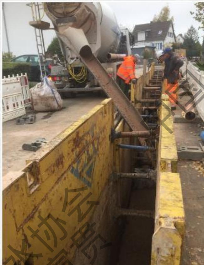
“可流动的回填材料”浇筑
