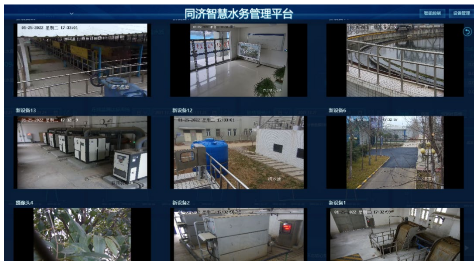
图 6-2 污水厂视频监控画面
