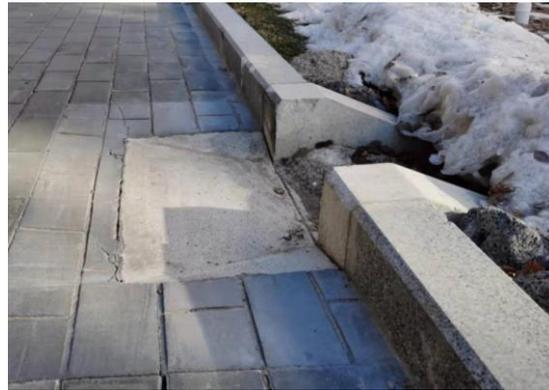
图 2 路缘石开口实景图（长春某小区）
