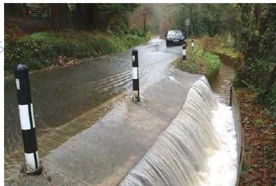
小区出入口径流通道
